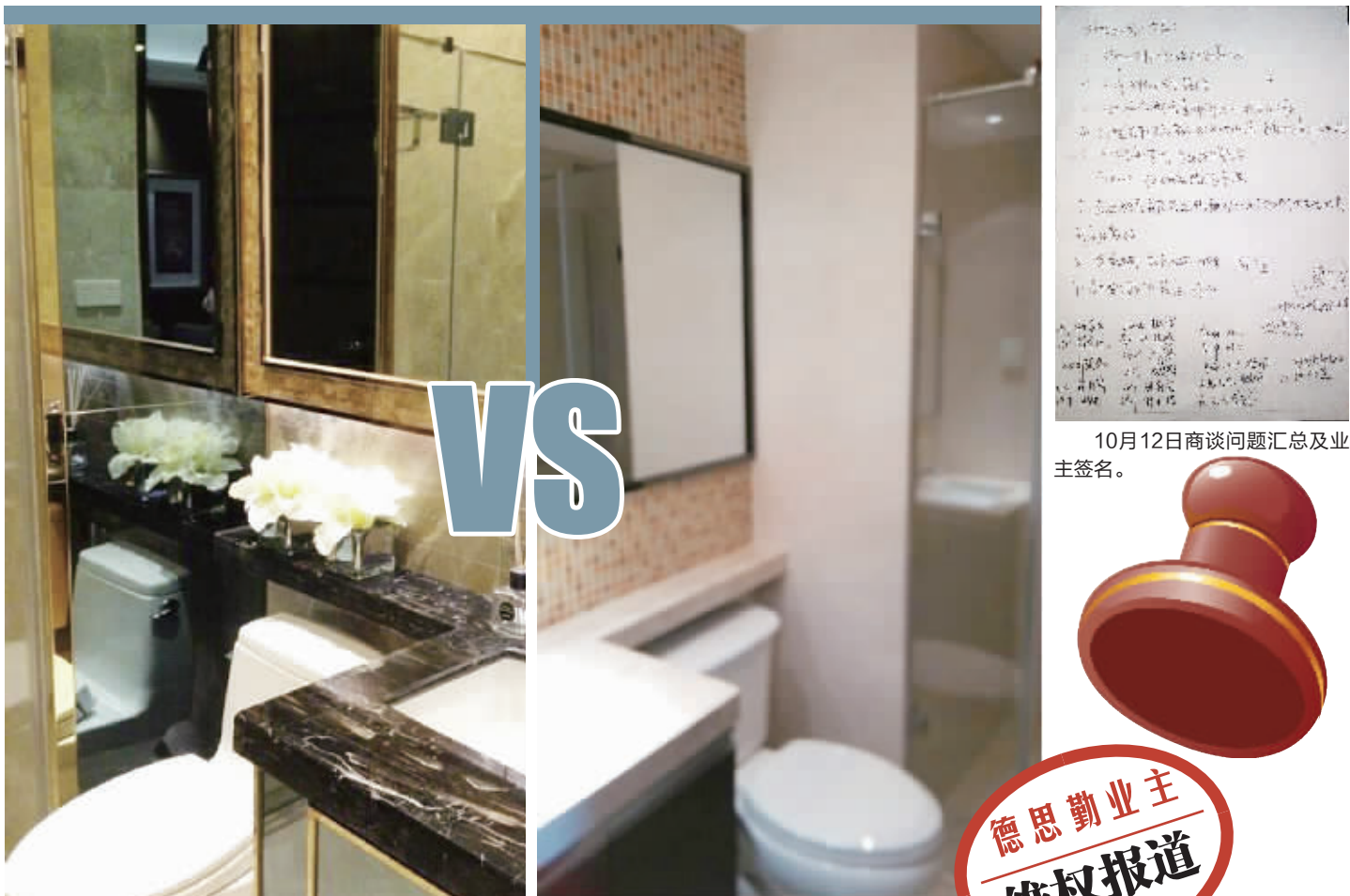
由业主提供的样板房与交付房卫生间照片对比。
