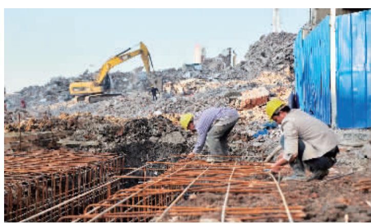
12月2日下午，长沙地铁1号线开福寺站建设工地，施工人员正在绑扎钢筋。目前，1号线最后三站开福寺站、湘雅路站、营盘路站已开始拆除所在区域的房屋，本月底即可正式开工。 记者 田超 摄
