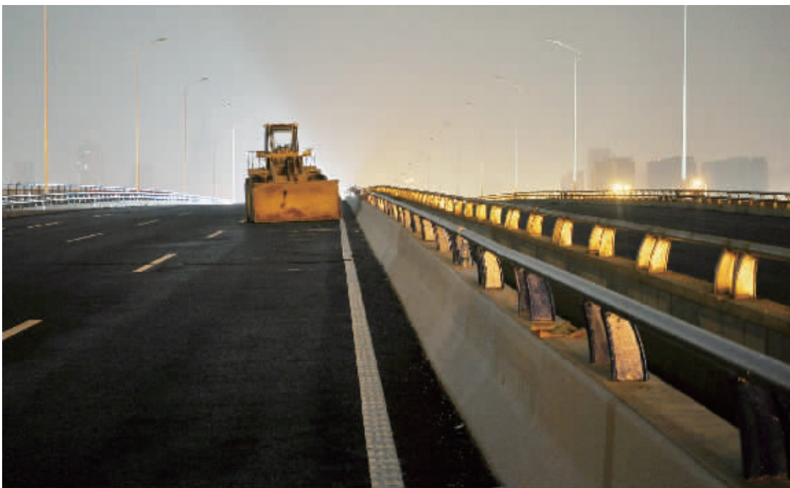
11月19日晚10点半,长沙市三一大道浏阳河桥面上工人正在连夜施工,大桥将于22日通车。 实习记者 李健 摄
