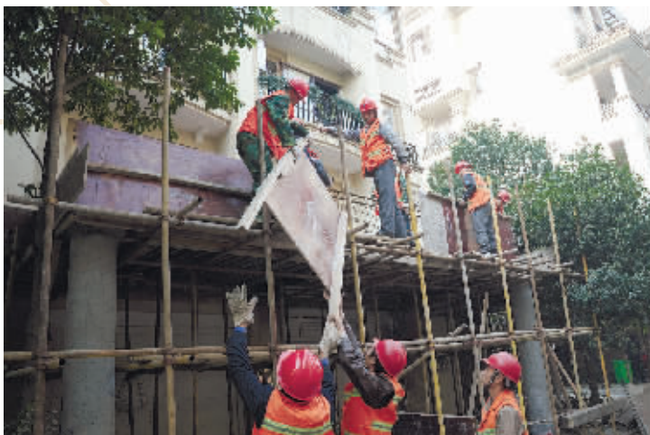
10月23日,长沙市芙蓉区某小区违规搭建现象严重,该区组织200余名执法人员依法对25户新建违法建筑进行拆除。
