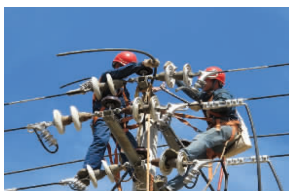
冒着酷暑抢修电力设施。
