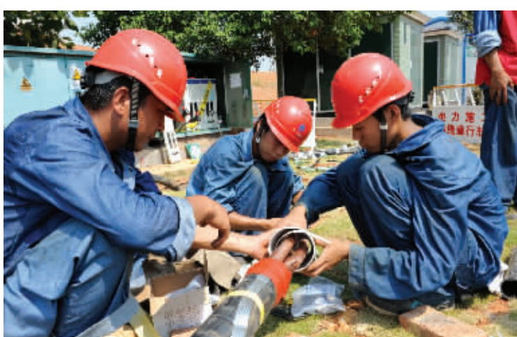
长沙地铁施工，电缆改道，烈日下电力一线工人在工作。
