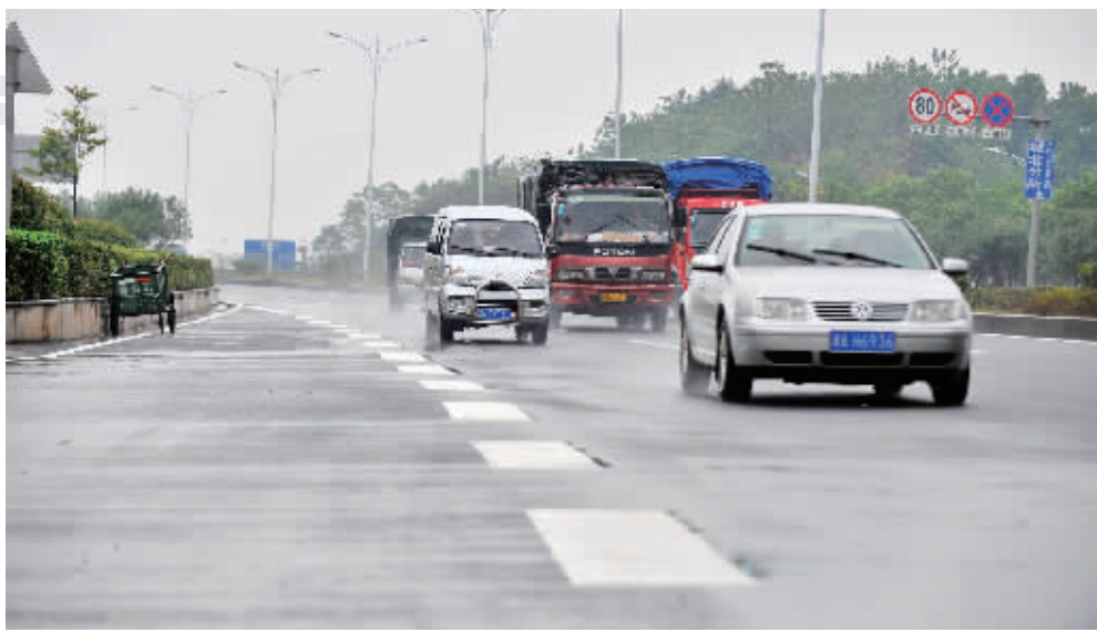
9月3日上午,长沙市西二环临三汊矶大桥段,很多机动车从路上驶过。西二环经过路面改造后已放开交通。 记者 田超 摄
