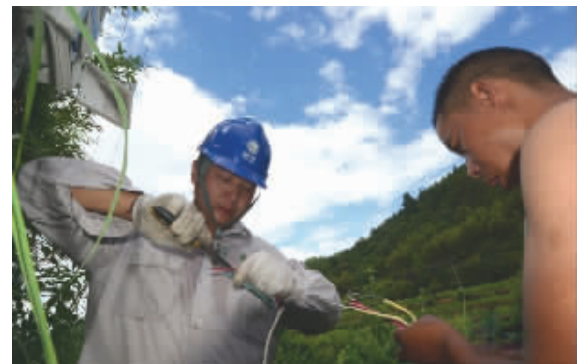
抗旱队员给村民安装临时用电装置。
