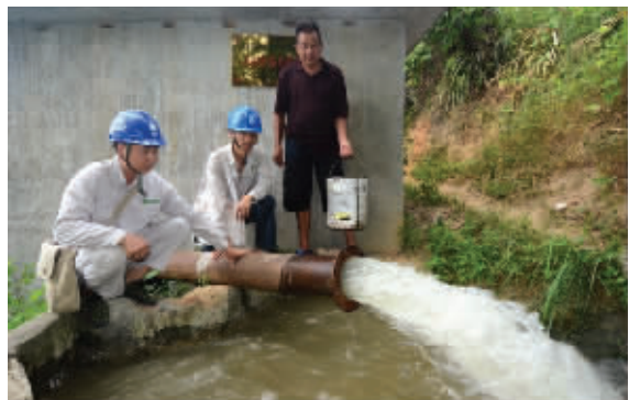
长铺乡哨溪村村支书看见修好的水泵,心里乐开怀。
