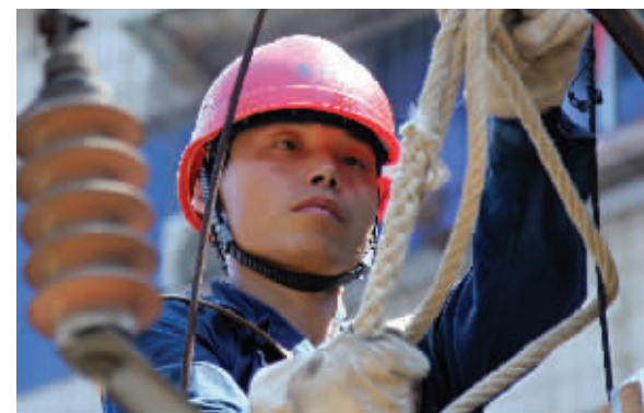
冒着酷暑抢修电力设施。
