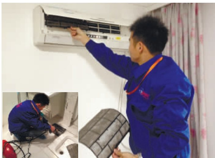
96258空调清洗师傅在市民家清洗空调。
