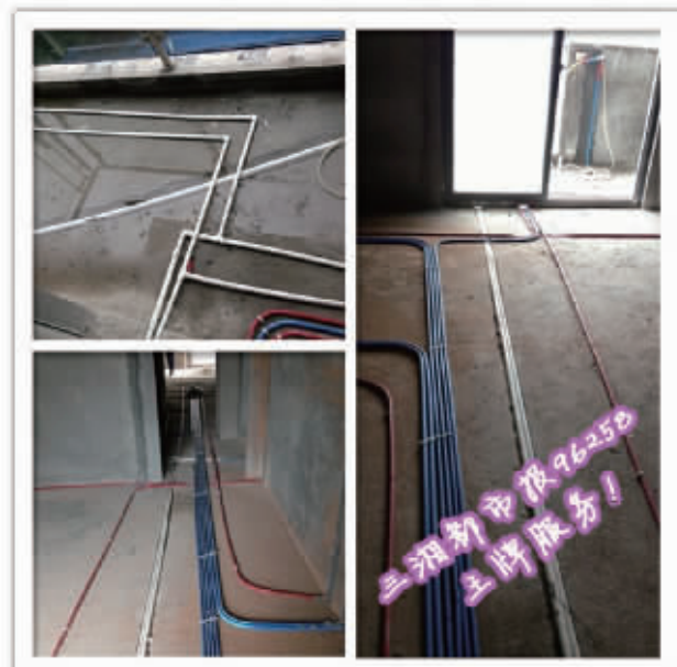
图为96258房屋装修师傅按照“横平竖直”的标准铺设电线、水管。
