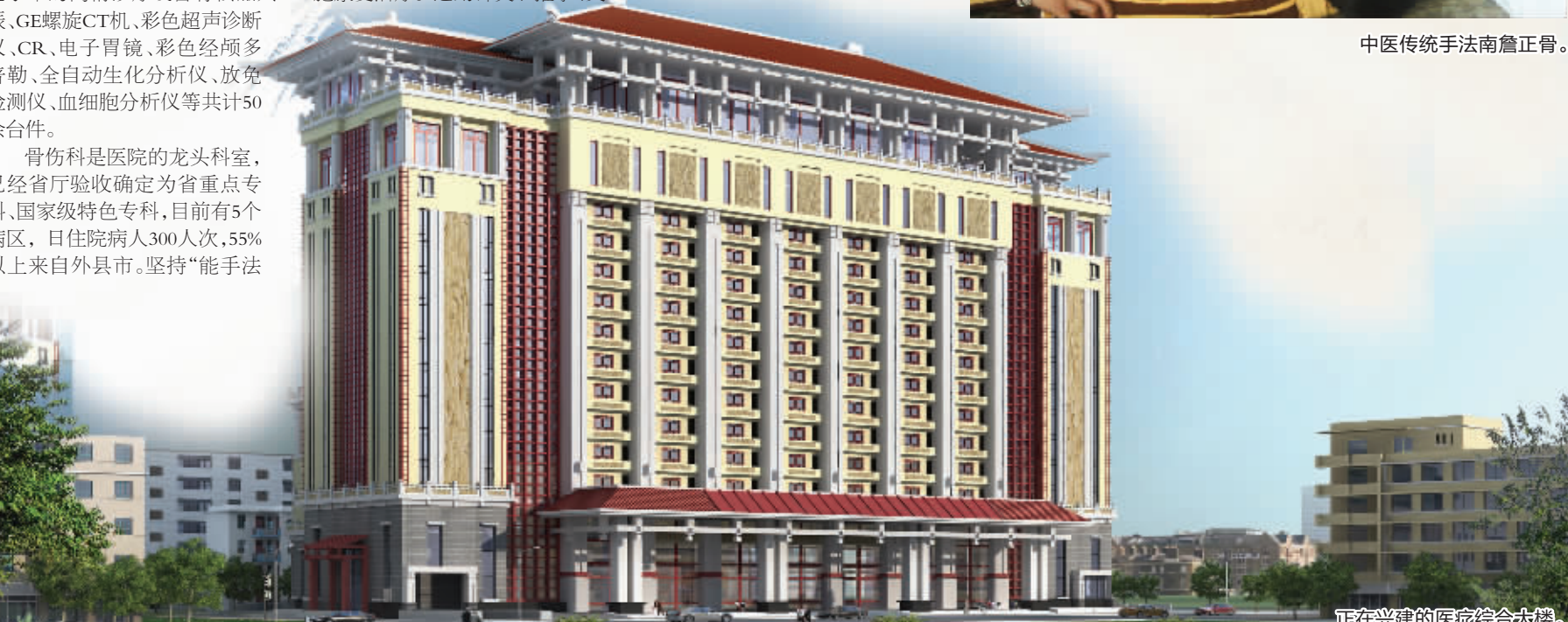
正在兴建的医疗综合大楼。
