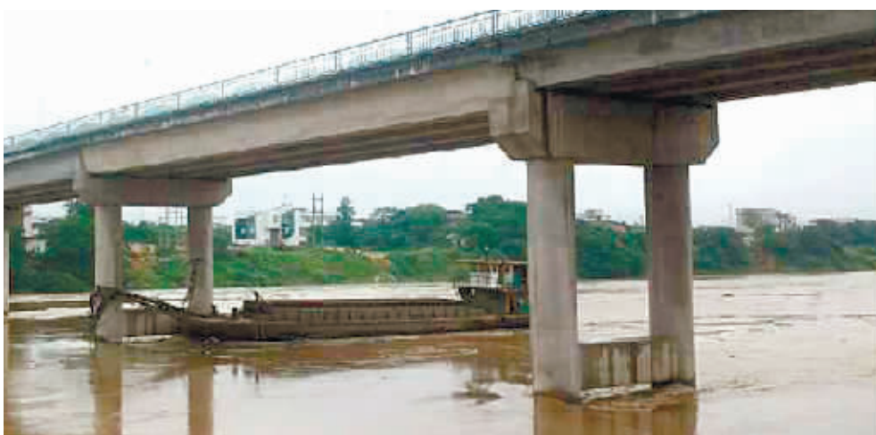
5月15日上午,一艘空载运砂船卡在涟水河大桥桥墩处。
