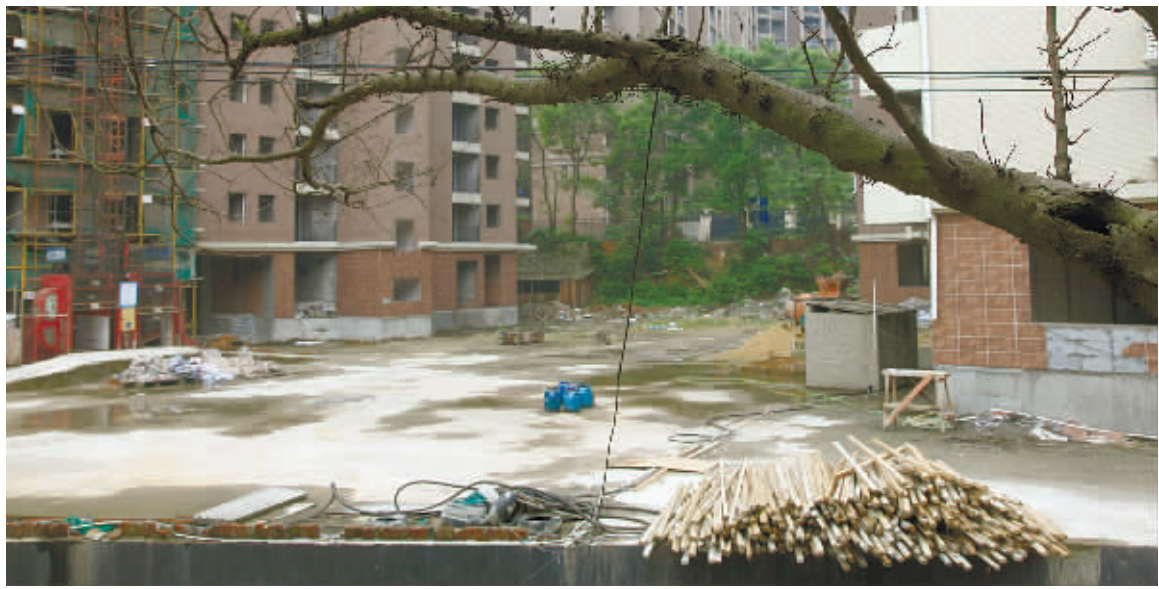
4月22日,枫树园二期工地上没有任何施工动静,建筑材料随意堆放在空荡荡的小区,显得格外荒凉。 记者 刘丰 摄
