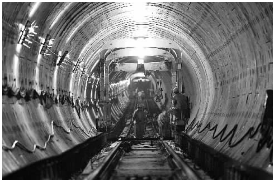
长沙发布今年重大项目,将续建地铁1、2号线。图为正在建设中的地铁2号线。
