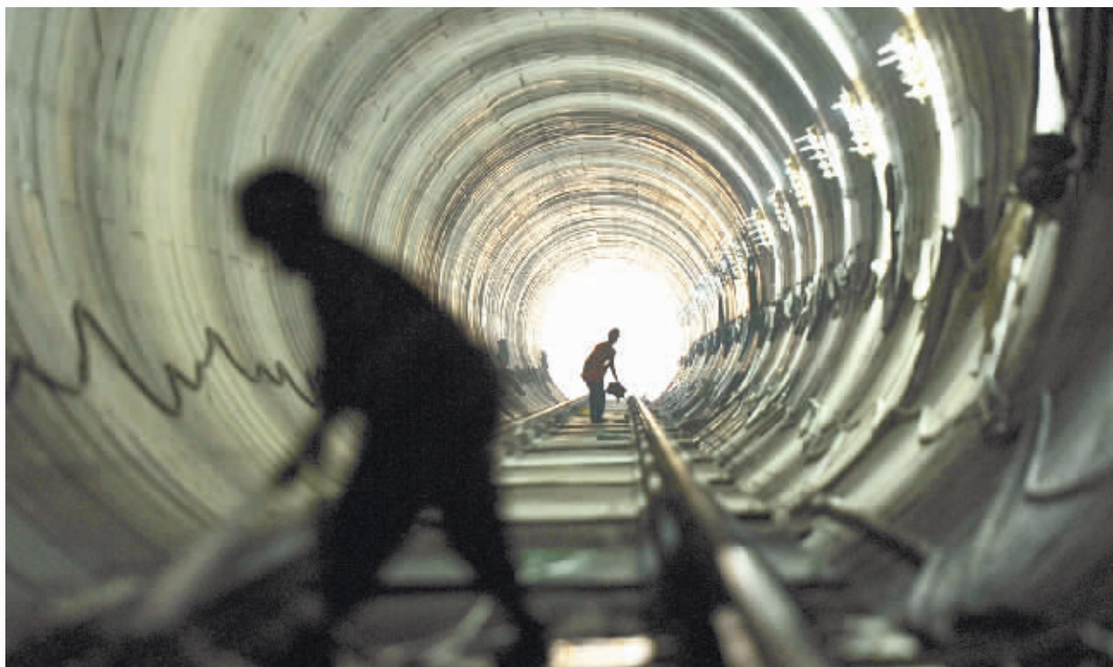
长沙地铁建设,为城市提速。记者 童迪 摄
