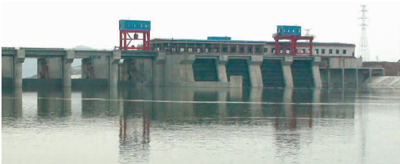
安江水电站坝顶。(资料图片)
