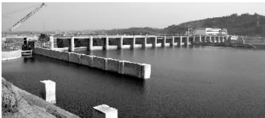
湘祁水电站首台机组顺利并网发电,开始试运行。(资料图片)
