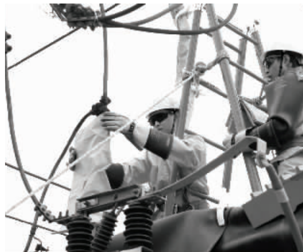
为了不断园区供电,郴州电业局积极推行带电作业。
