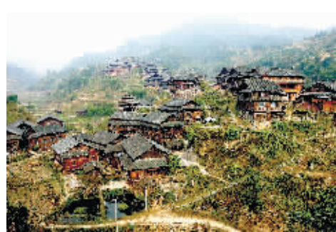
“国保”芋头侗寨古建筑群,结构造型具有典型的侗族风格,被古建筑专家和文物专家称为侗民族建筑的“实物博物馆”。
