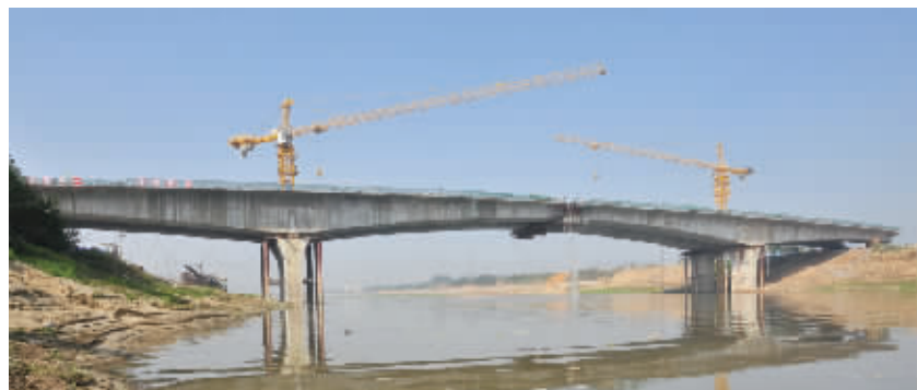
11月13日，长沙市车站北路捞刀河大桥主桥全面合龙。
