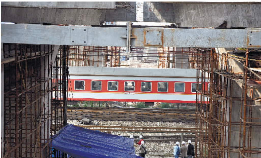
10月25日,长沙市湘府路湘江大桥成功上跨京广铁路线,预计年底竣工通车。 实习生 唐俊 摄
