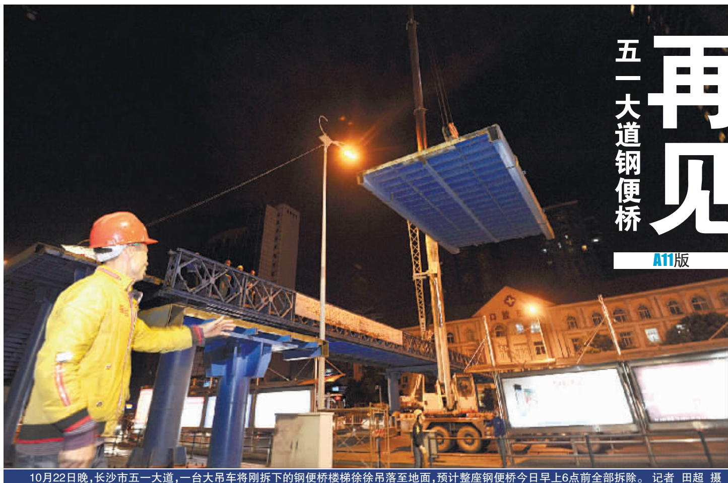
10月22日晚,长沙市五一大道,一台大吊车将刚拆下的钢便桥楼梯徐徐吊落至地面,预计整座钢便桥今日早上6点前全部拆除。记者 田超 摄
