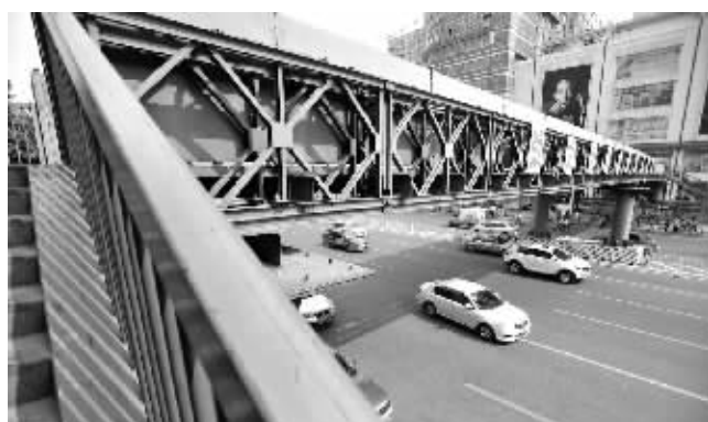
服务两年的五一广场钢便桥将拆除。记者 田超 摄
