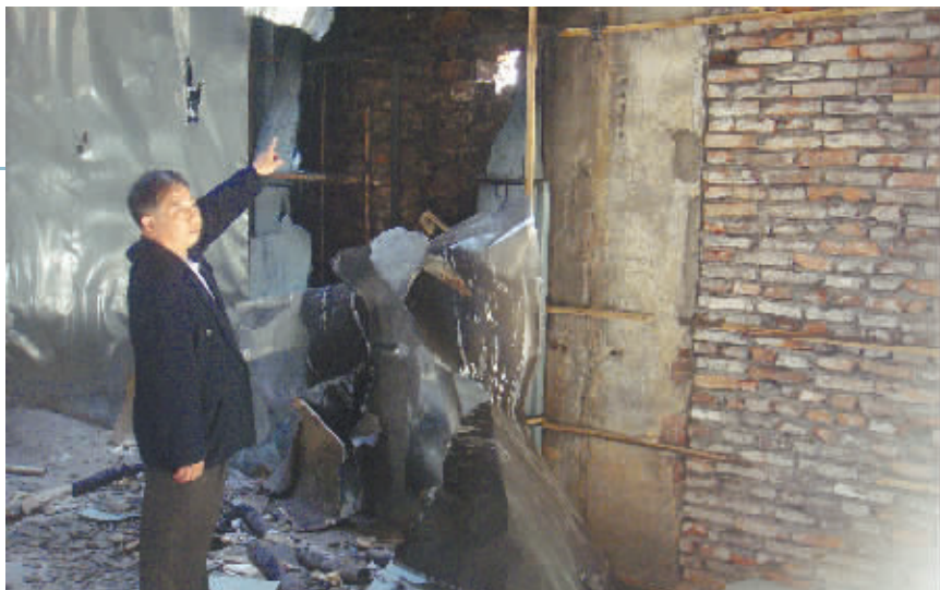
湘潭诚信冷冻冷藏食品有限公司的这个“空壳冷库”十分简陋,里面空空荡荡,破损不堪。 记者 刘晓波 摄
