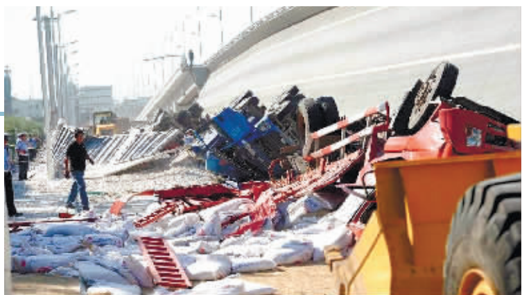
8月24日,哈尔滨市三环路高架桥福路上行匝道处发生倾覆。
