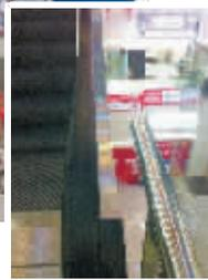
间,并没有安装阻挡装置。根据今年8月1日正式实施的《自动扶梯和自动人行道的制造与安装安全规范》国家标准(GB16899-2011)中5.5.2.2条规定:如果存在人员坠落的风险,应采取适当措施阻止人员爬上扶手装置外侧,为确保这一点,自动扶梯和自动人行道的上盖板上应安装设防爬装置。当自动扶梯或自动人行道与墙相邻且外盖板宽度大于125毫米时在上下端部都应安装阻挡装置。
