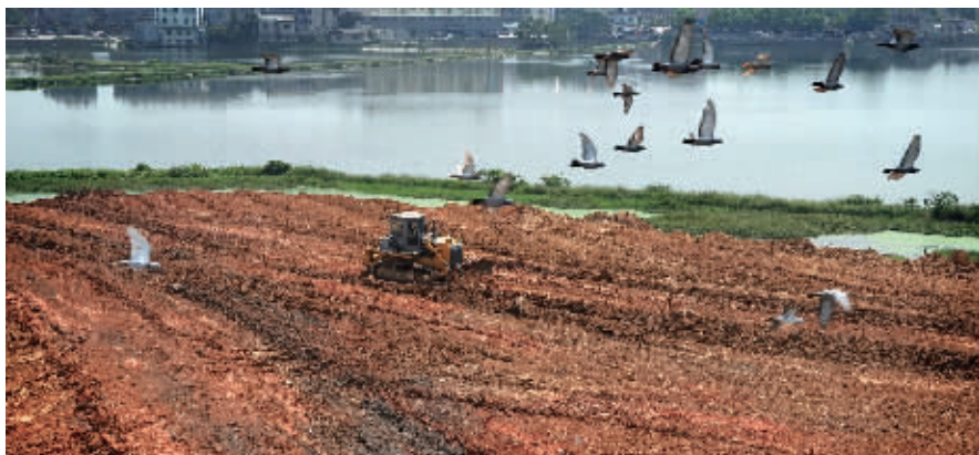
8月30日，岳麓山风景区后湖景区，一台推土机正在平整填湖的土方。
