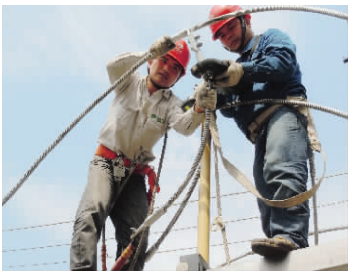
电力员工战高温,抢修排障保供电。
