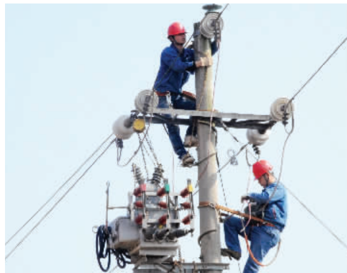
加速农网改造施工。
