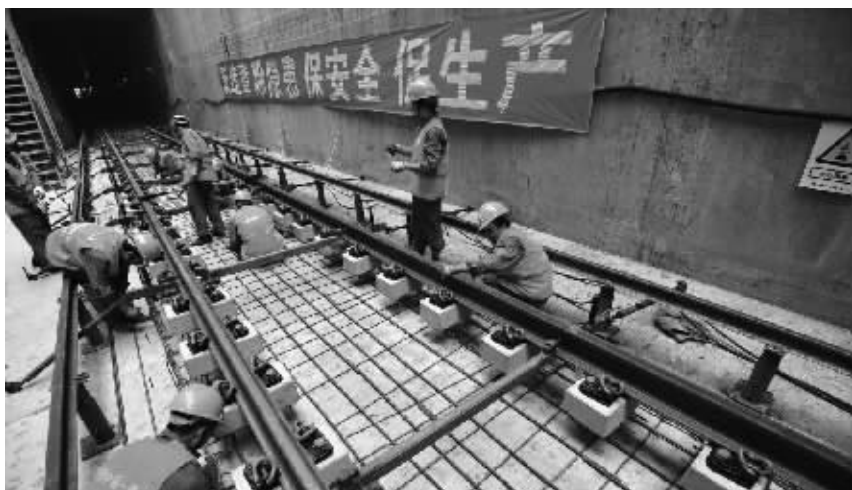
8月3日，长沙市长沙大道地铁站施工现场，施工人员在地铁隧道内铺轨。 记者 李丹 实习生 李际 陈俊筱 摄
