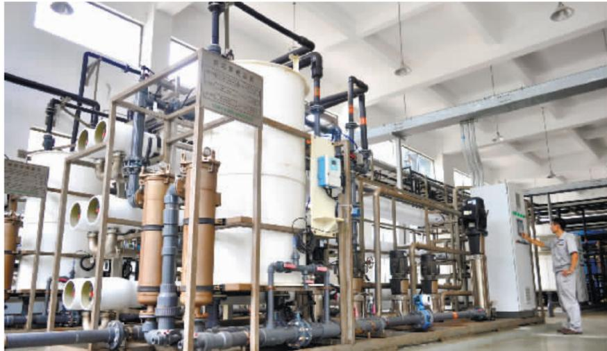
垃圾渗滤液处理厂工作人员操作设备净化渗滤液,使其能安全无污染地排放。
