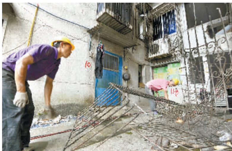
7月24日下午，长沙市开福寺路福源公寓，两名工人在拆卸已搬迁住户的旧防护窗。该公寓目前有不少住户已搬迁。 记者 田超 摄
