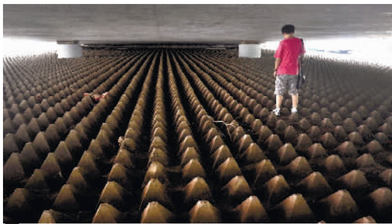
7月5日,长沙市南郊公园新开辟立交桥下整齐地摆放着水泥锥。实习生李健 摄
