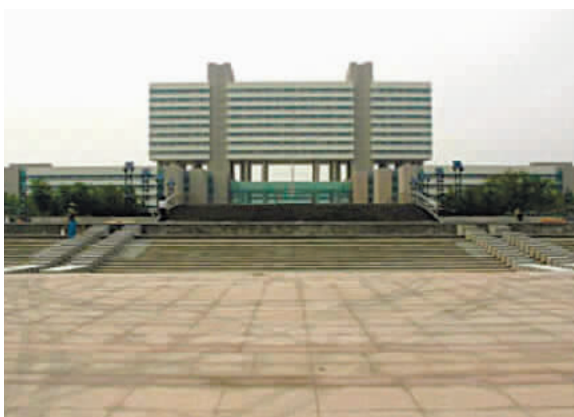
▲黄胜在德州修建的“黄”字形办公楼被戏称为“黄楼”。
