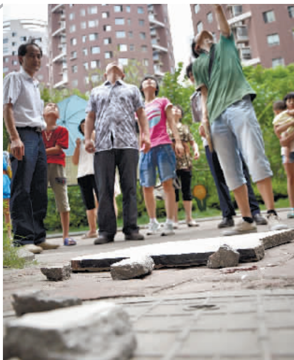
7月4日,西岸润泽府小区,墙面砖块坠落。实习生 唐俊 摄
