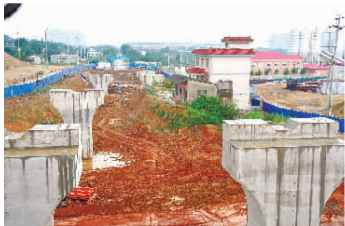
6月25日下午,长沙车站北路捞刀河大桥工地,因北岸两栋房、南岸一栋房卡住引桥路幅,车站北路捞刀河桥无处“落脚”。
