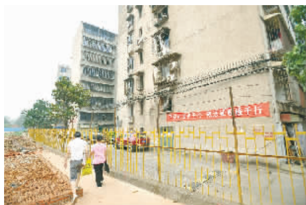
6月14日,长沙市开福寺路福源公寓,每栋房子上都挂着拆迁动员标语。 记者 田超 摄
