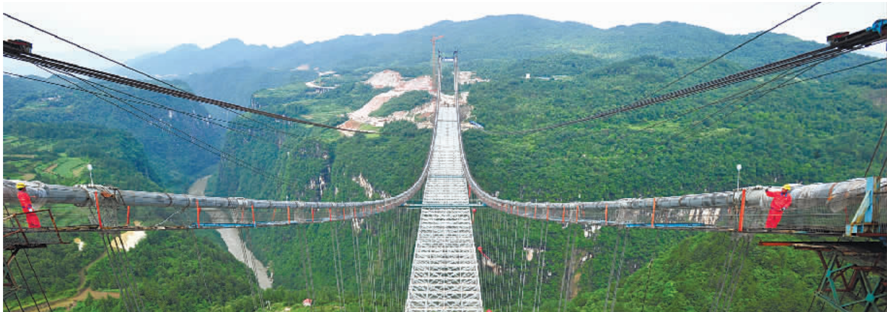
6月11日,张花高速澧水特大悬索桥成功合龙,标志着大桥主体结构完工。目前,该桥是我省第二大跨径悬索桥。 记者 郭立亮 摄
