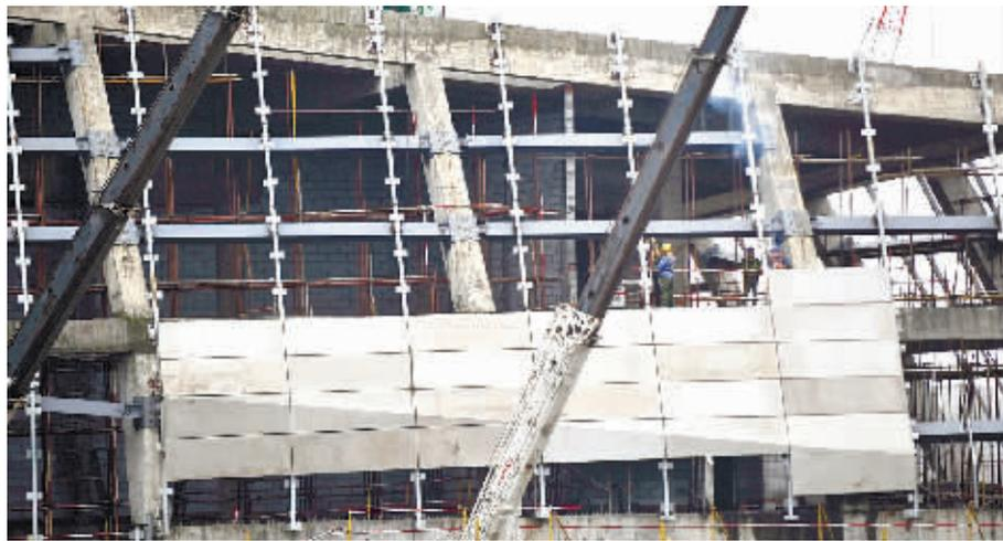
6月7日下午,长沙市新河三角洲两馆一厅建设工地,工作人员正在安装外墙清水混凝土挂板。 记者 田超 摄
