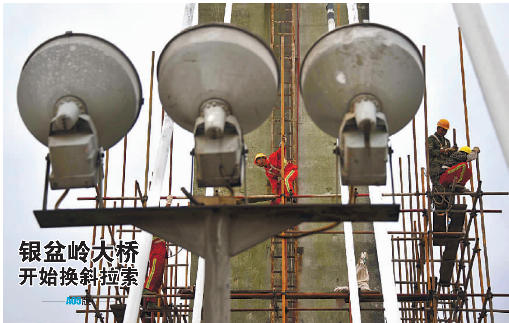
银盆岭大桥于日前开工更换斜拉索,工程将持续5个月,完成60对斜拉索的更换任务。5月28日,工程人员在即将更换的旧“斜拉索”旁架设施工平台。
