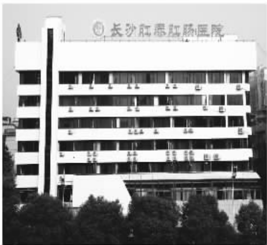
医院门诊大楼实景拍摄
