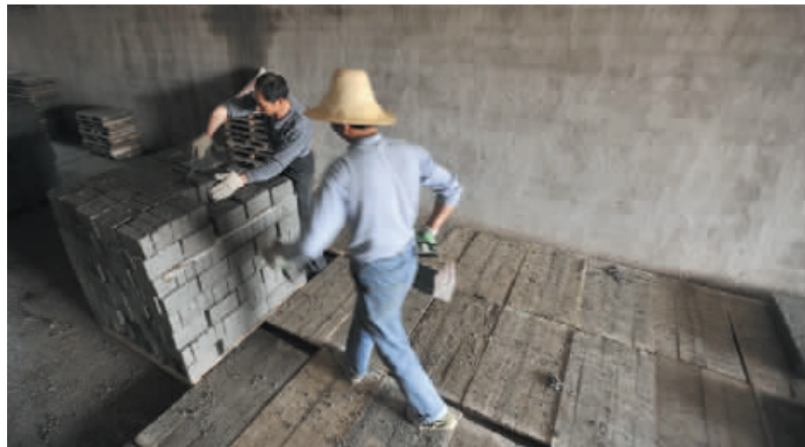
4月19日,长沙市开福区捞刀河镇,工人在搬运由建筑垃圾压制而成的混凝土砖。
