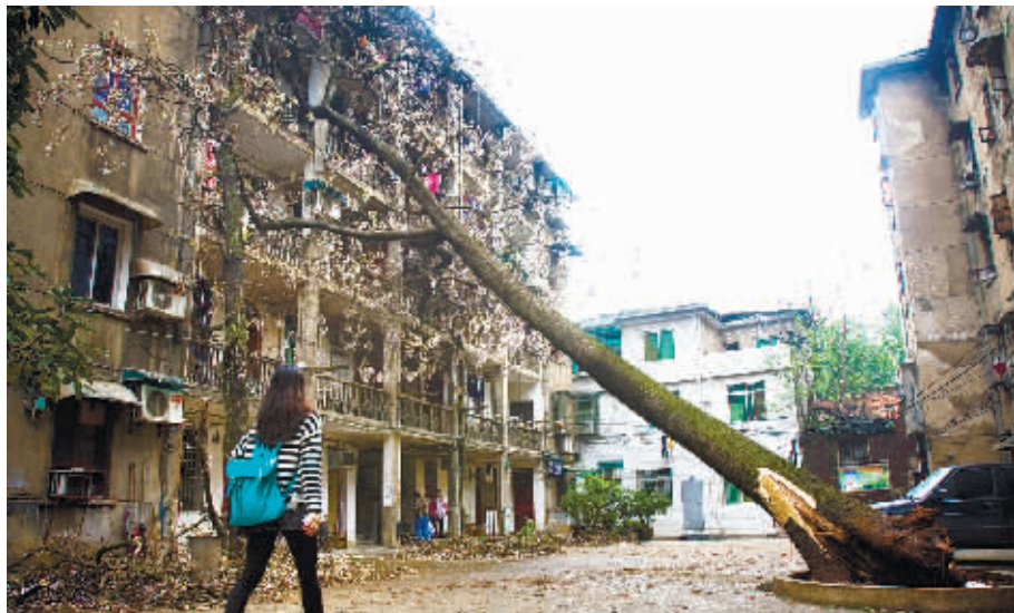
4月16日,长沙市潮宗街潮宗里9号楼被一株泡桐树砸到了。记者 李丹 实习生 骆毅 摄
