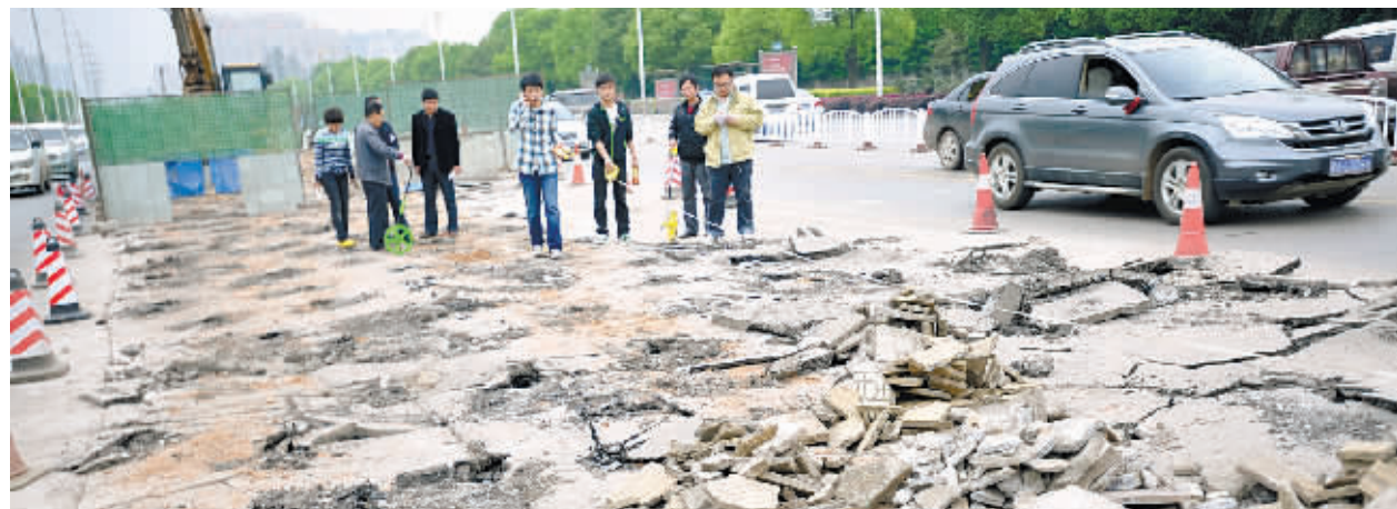
4月9日下午,长沙市万家丽中路,施工人员在这一段破损的路面进行翻修。 记者 田超 摄
