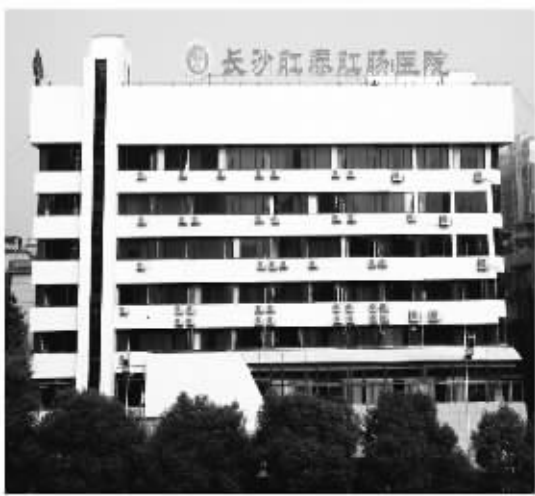
医院门诊大楼实景拍摄
