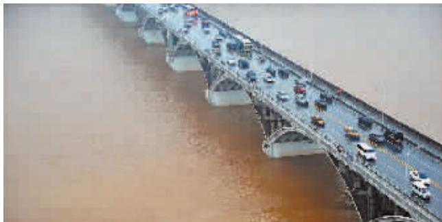
大洲桥(3月8日摄)。
