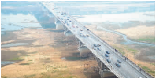
大洲桥(2011年10月摄)。
