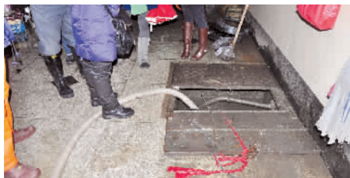
3月8日,长沙市太平街地下通道,水泵正在向外抽水。
