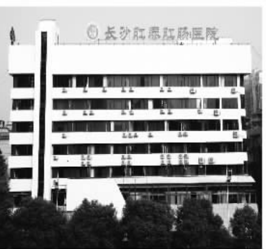
医院门诊大楼实景拍摄
