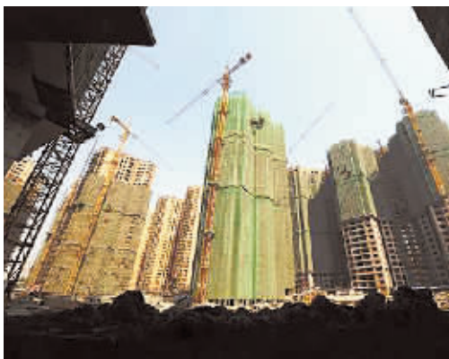
长沙市一处保障房施工现场。(资料图片)
