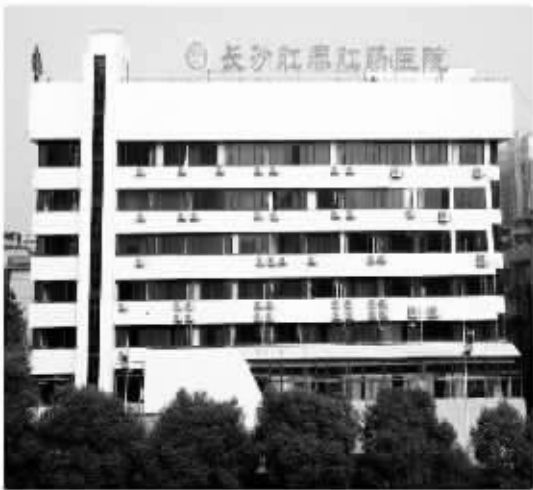
医院门诊大楼实景拍摄
