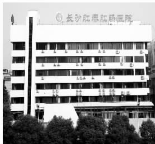
医院门诊大楼实景拍摄
