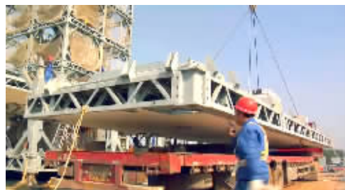
平板车把生产好的钢结构模块拖到工地。
