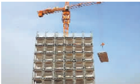
像搭积木一样，吊车依次组装到位。
